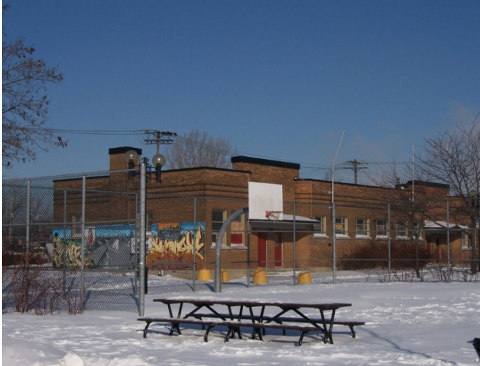
L'édifice Ovila-Pelletier transféré par la Ville de Montréal. Photo : Ron Rayside Architectes
